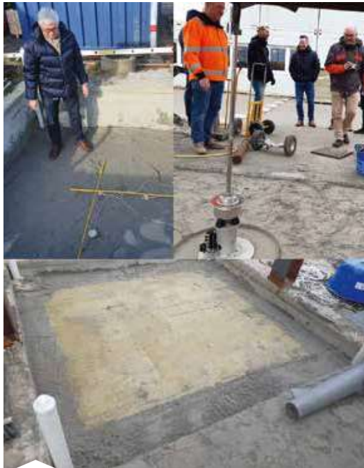
Forsøgsbefæstelse, øverst: installation af trykceller, måling på færdig overflade, nederst: overside af Rockflow lag inden indbygning af stabilgrus.
