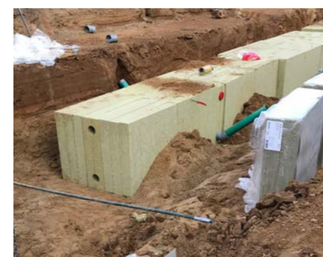
Indløb fra vejbrønd sker via den nederste udskårne kanal i Rockflow som vist på fotoet.
